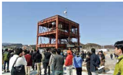
▲東日本大震災被災地の現場における研修例
